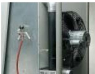
Situato in prossimità dello scambiatore, interviene sul circuito valvola gas e protegge lo scambiatore da eventuali surriscaldamenti.
