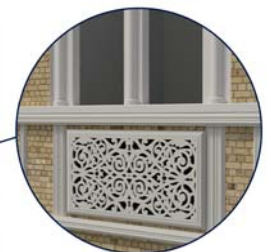
Ventilazione su elemento lapideo
